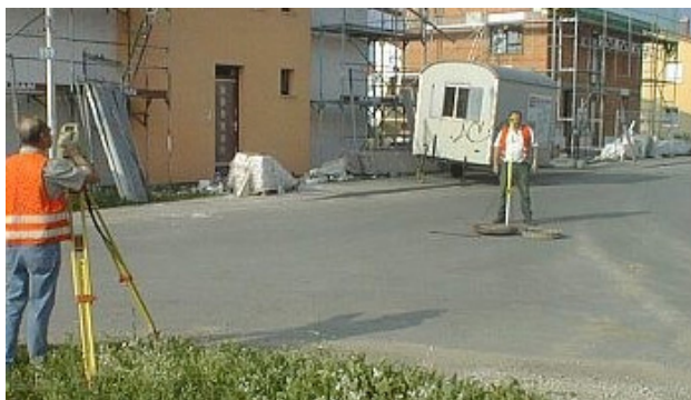
Abbildung: Erfassung von Versorgungsleitungen
